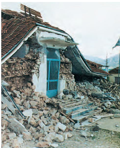
Εικόνα 27.1α: Καταστροφή από σεισμό
