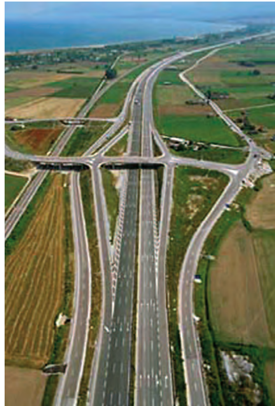
Εικόνα 41.3: Π.Α.Θ.Ε. Νέα Εθνική Οδός. Τμήμα: Δίον-Κατερίνη
