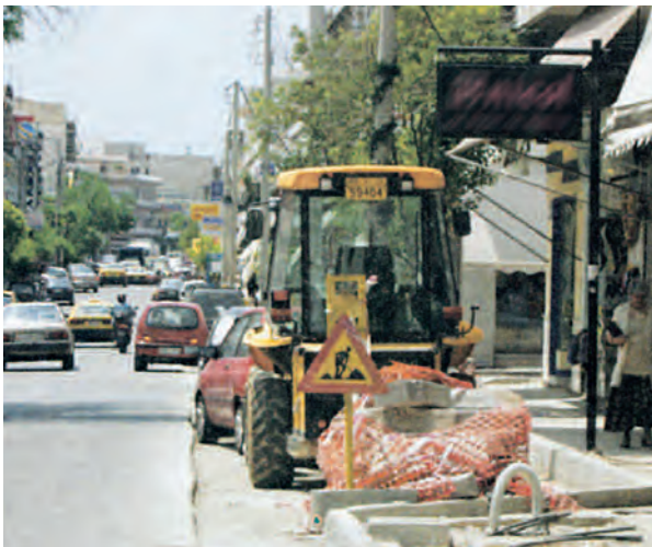
Εικόνα 31.1: Κατασκευή νέων πεζοδρομίων
