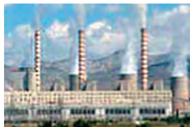
Εικόνα 38.3: Εργοστάσιο ηλεκτροπαραγωγής στην Πτολεμαΐδα
