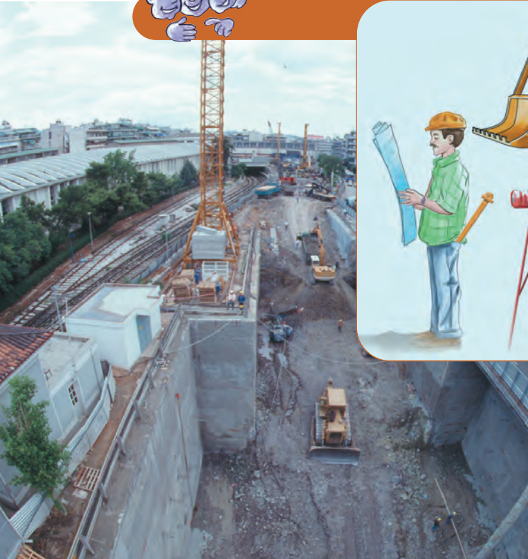
Ένας σταθμός κατασκευάζεται
