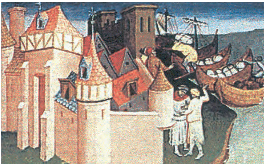
3. Βενετοί έμποροι στο λιμάνι του Γαλατά.
