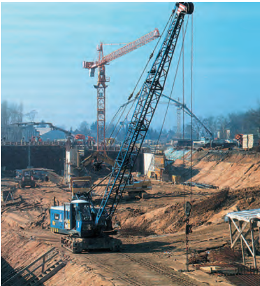
Εικόνα 23.2: Κατασκευή δρόμου στη Γερμανία
