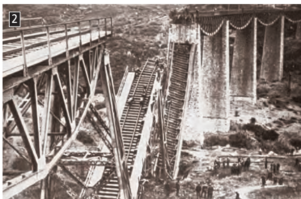
▲ Η γέφυρα του Γοργοποτάμου που ανατινάχθηκε από τις αντιστασιακές δυνάμεις, φωτ. Αρχείο ΔΟΛ
