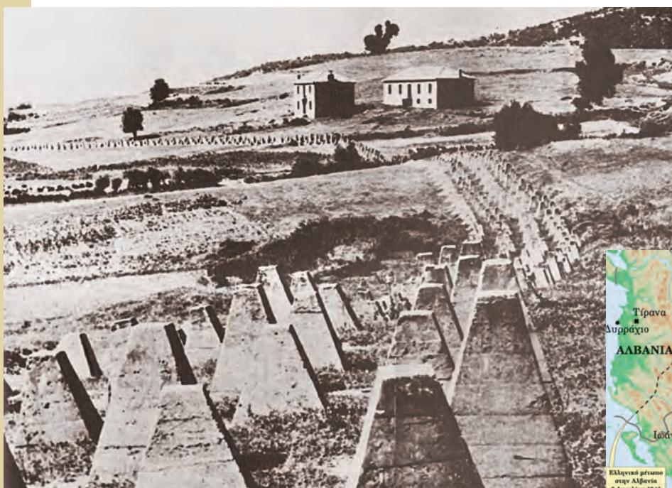
▲ Ανταρματική οχύρωση στην τοποθεσία Μπέτλες – Νέστος, Αθήνα, Πολεμικό Μουσείο
